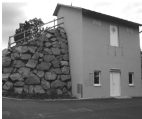
Aussenansicht des Wasserbehälters
